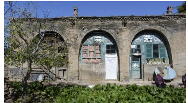
Maisons voûtées en brique avec remplissage en terre
