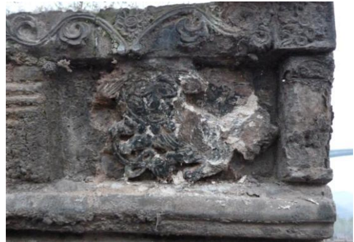
Rive de toiture du temple: sculpture dégagée
