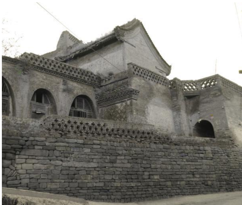
1. Vue du temple depuis la rue
