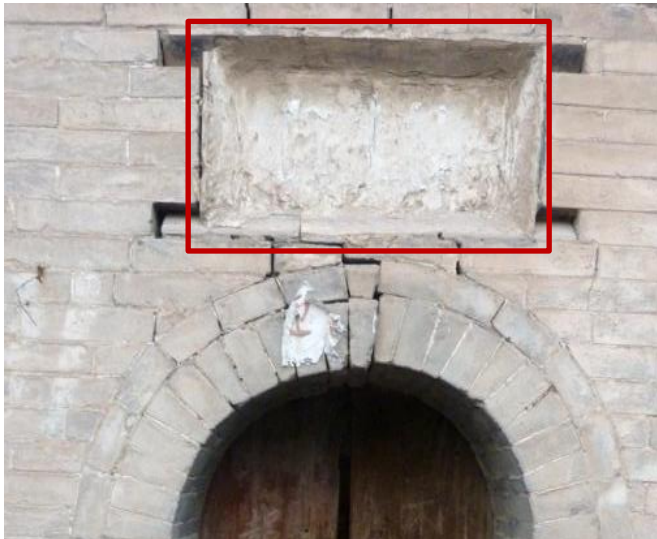
Une des portes d'entrée du temple: écriture occultée
