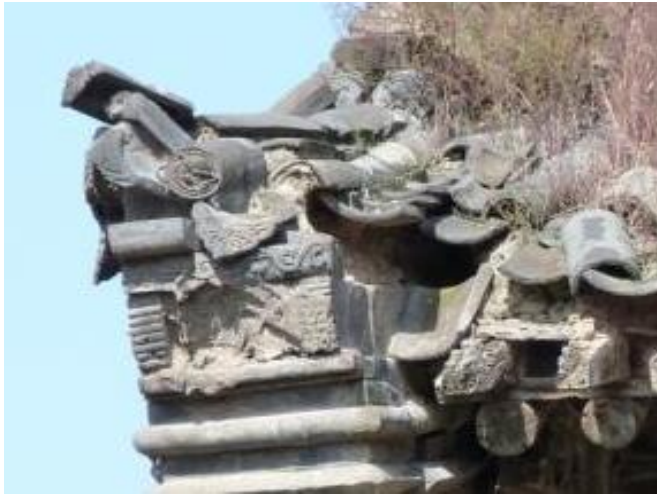
Rive de toiture du temple: résistance passive
