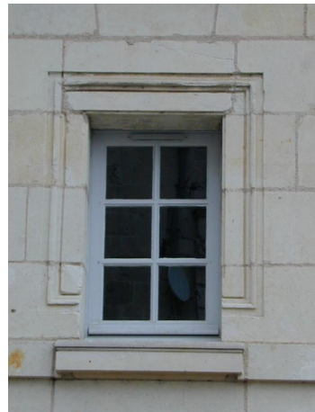
Petite fenêtre à grands carreaux, encadrement et appui mouluré Renaissance en pierre de taille
