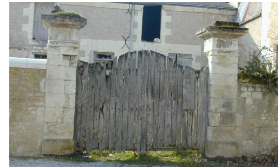
Piles de pierre de taille et portail bois à lames verticales, découpe en "chapeau de gendarme". Mur plein de moellons, finition joints beurrés, couronnement cintré en pierre de taille
