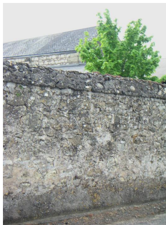
Couronnement constitué d'une dalle de pierre surmontée d'un blocage en moellons hourdé au mortier de chaux
