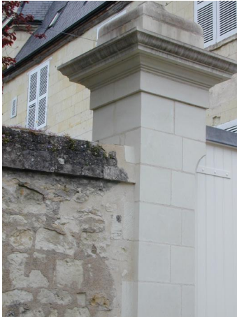
Détail de couronnement de pile en pierre de taille
