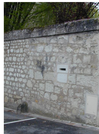
Parement de moellons hourdé à la chaux, à joints beurrés (recouvrant partiellement les moellons)
