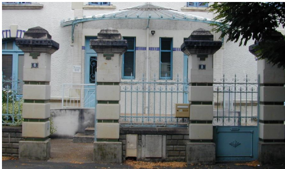
Entrées de maisons jumelles à piles de pierre de taille, faisant référence aux modèles traditionnels. Portes fer à soubassement plein et barreaudage vertical
