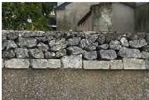
Couronnement constitué d'une dalle de pierre surmontée d'un blocage en moellons hourdé au mortier de chaux
