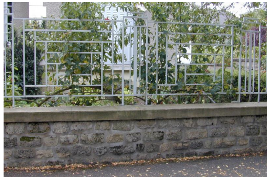
Soubassement moellons joints ciment en creux, couronnement ciment lissé, grille fer à section carré, dessin géométrique simple
