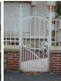
Porte piétonne et portail fer s'inspirant du style art nouveau (1910) piles brique rouge à couronnement de pierre de taille, mur bahut et grille (voir ci-dessus)
